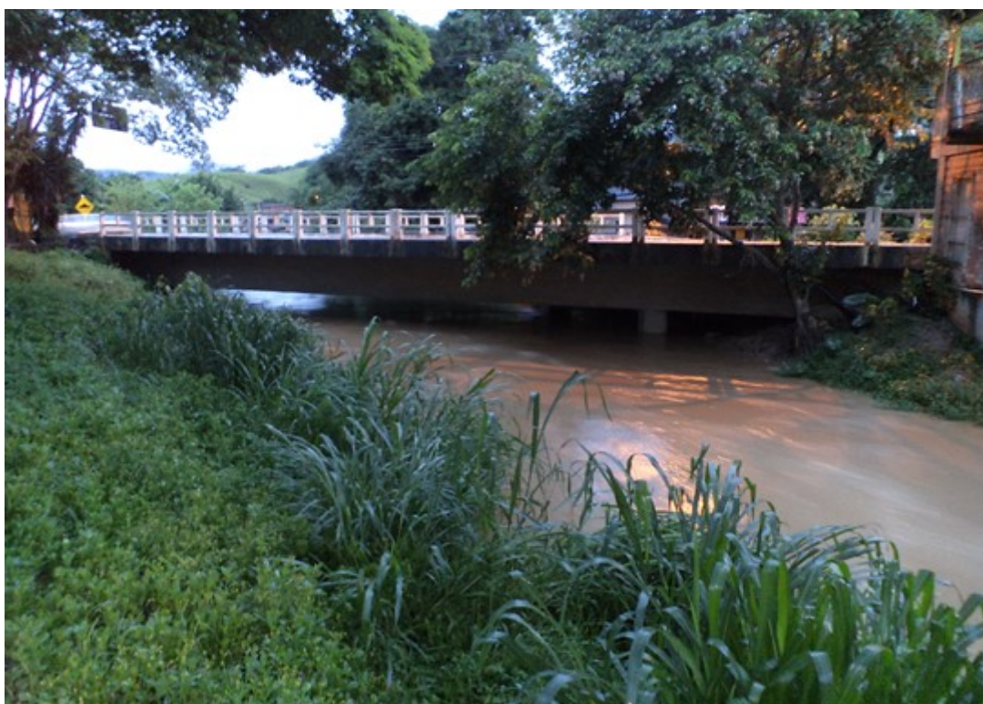
Figura 28: Ponte Emílio Coelho da Rocha 25/12/2013.
