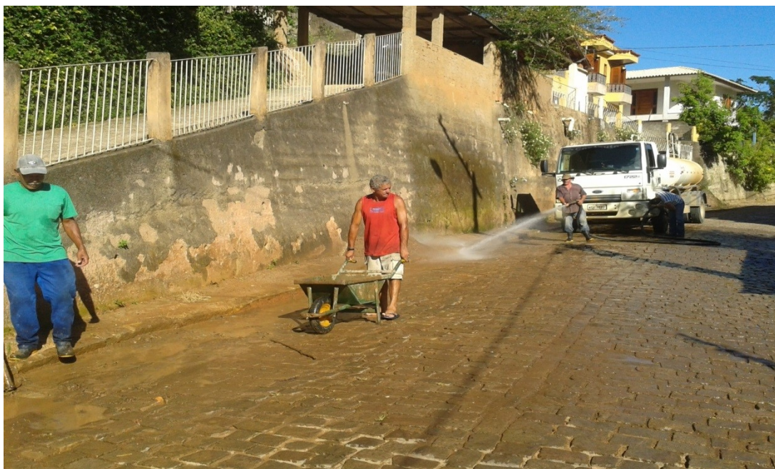
Limpeza da Rua Leonarda Fraga – 05/02/2014.
